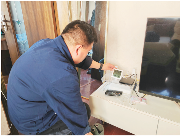
供热人员正在安装检查室温采集器。 本报记者 马嫣婕 摄
